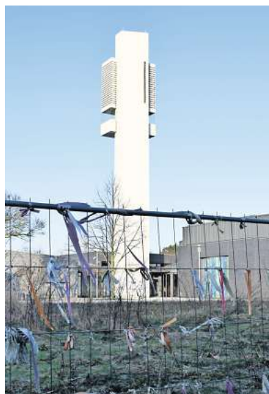
Auf der Südseite der Kirche, wo an einem Bauzaun immer noch Solidaritätsbändchen an den Brand 2013 erinnern, soll ein viergeschossiger entstehen.
